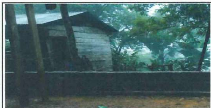
Foto 5: Se mejorara las hiladas de block de las paredes de la escuela.
