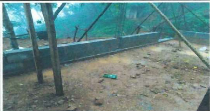
Foto 1: La escuela cuenta con dos hiladas de block columnas de concreto, la base de concreto y así mismo ya cuenta con hierro.
