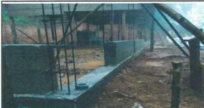
Foto 4: Se mejorara las hiladas de block de las paredes de la escuela.
