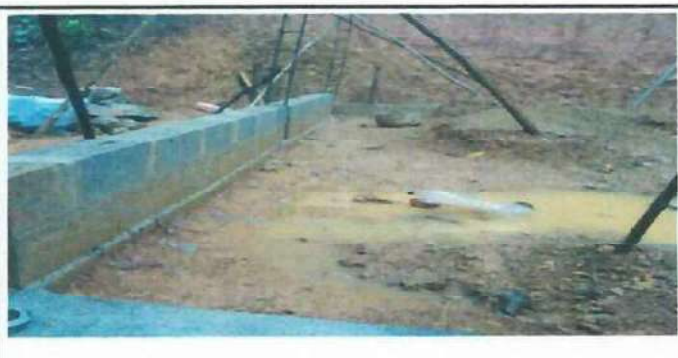
Foto 6: Se mejorara las hiladas de block de las paredes de la escuela.
