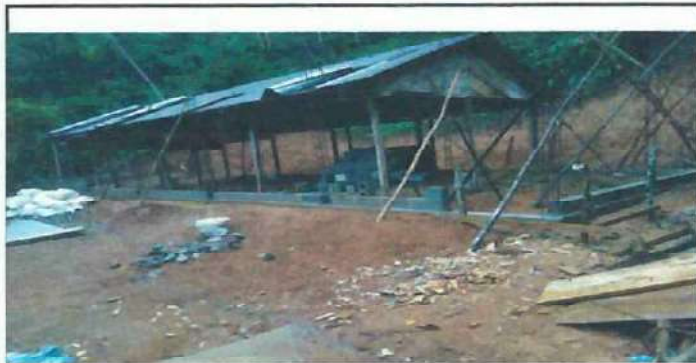
Foto 3: Se mejorara y ampliara las hiladas de block de las paredes de la escuela.
