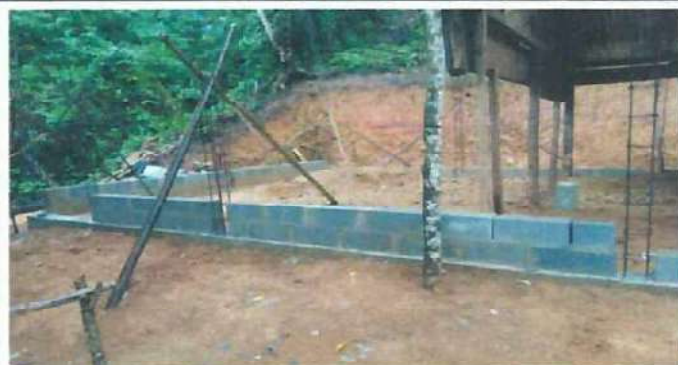
Foto 2: Se mejorara las hiladas de block de las paredes de la escuela.
